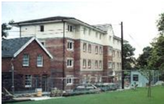
شکل ۹ و ۱۰: سیستم جعبه ای که، تشکیل شده از دیوارها، سقف و کف، که با تریلر به سایت حمل شده و توسط جرثقیل در محل‌های تعیین شده جا گذاشته میشوند.
