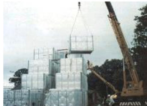
شکل ۹ و ۱۰: سیستم جعبه ای که، تشکیل شده از دیوارها، سقف و کف، که با تریلر به سایت حمل شده و توسط جرثقیل در محل‌های تعیین شده جا گذاشته میشوند.
