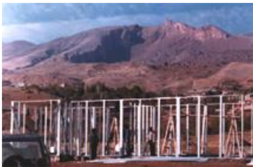
شکل ۱۲: استفاده از سیستم LSF برای ساخت مراکز بهداشتی
