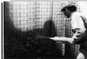
شکل ۶. بتن‌پاشی روی دیوار در سیستم ساختمانی 3D
