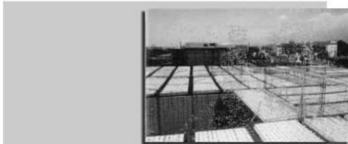
شکل ۵. سقف‌زنی در سیستم ساختمانی 3D
