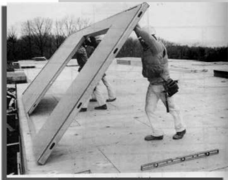
شکل ۱۵. شیوه نصب دیوار پانلی در سیستم LSF
